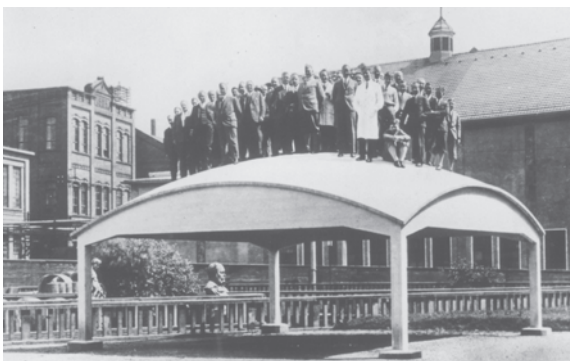
Abbildung 1.18 Dischinger-Schale; Versuchsbelastung durch die Mitarbeiter des DYWIDAG-Konstruktionsbüros (1931)
