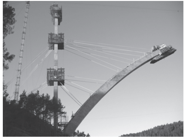
Abbildung 1.22 Herstellung des Bogens einer Talbrücke – Brücke über den Svinesund zwischen Schweden und Norwegen (2005); Spannweite 247 m; Herstellung des Stahlbetonbogens im Freivorbau Blaschko u. Torka (2005)
