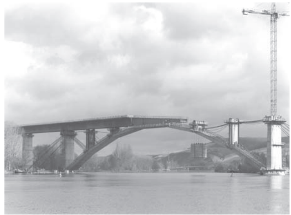
Abbildung 1.5 Maintalbrücke Veitshöchheim, DB-Hochgeschwindigkeitsstrecke Würzburg-Fulda; Stahlbeton-Stabbogen, Spannbetonhohlkasten (Der im Taktschieben hergestellte Hohlkasten wird im Bild gerade über den Bogen geschoben; der an der rechten Bogenhälfte angehängte Ballast dient zum Ausgleich der für Bogen ungünstigen exzentrischen Belastung.) (vgl. Naumann u. a. 1988)
