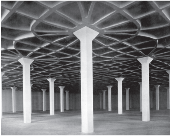
Abbildung 1.1 Stahlbetondecke, Entwurf Pier Luigi Nervi (1953) – die Form folgt der Richtung der Hauptmomente (aus Nervi u. a. 1957)
