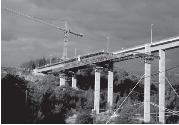
Abbildung 1.23 Bau einer Spannbetonbrücke mit Vorschubrüstung heute
