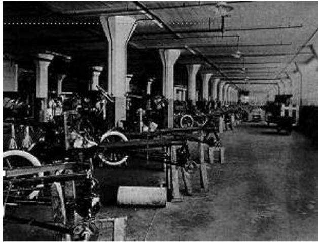
Abb. 2.69 Stationäre Montage (Bildnachweis: Ford)
