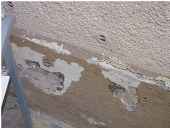
Abb. 2.53 Belüftungsröhrchen nach Knapen, sog. Mauerlunge
