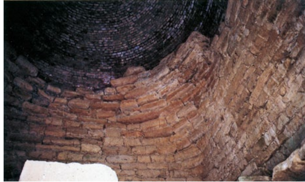
Abb. 2.4 Italien, Vetulonia. Etruskisches Kammergrab mit einem Kraggewölbe
