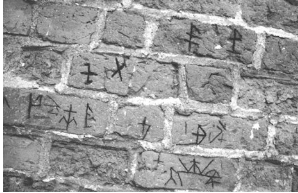
Abb. 2.39 Burg auf Fehmarn, Kirche. Mauerwerk mit Urhebermarken
