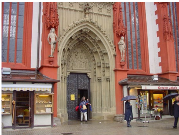
Abb. 2.33 Würzburg, Frauenkirche. Gotisches Portal mit Architekturdekoration. Die Quader am rechten Stützpfeiler wurden überfasset und dadurch vergrößert und geschönt
