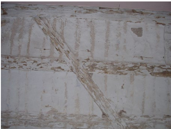
Abb. 2.55 Erlangen-Bruck. Mit Lehm ausgemauerte Fachwerkkinnenwand
