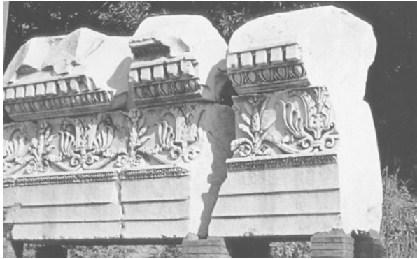
Abb. 2.31 Rom, Basilica Aemilia. Gebälk, bestehend aus dreifach gegliederten Architrav, mit Ranken verziertem Fries und oben das Sima des Kranzgesimses
