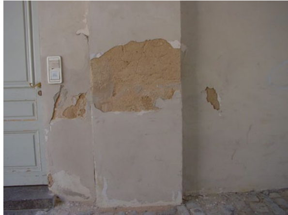
Abb. 2.54 Lehmputz auf der Wand unter Kalkfarben
