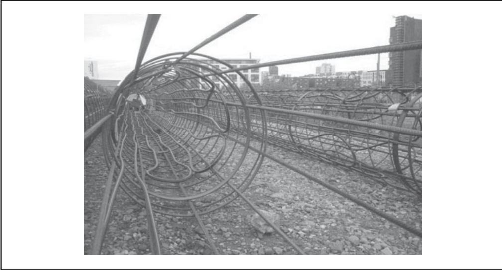
Abb. 4.5-5 Bewehrungskorb eines Energiepfahls
