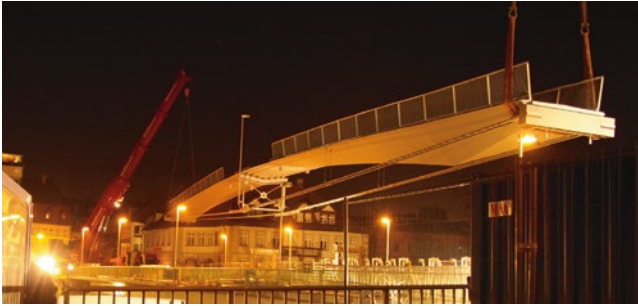
Bild 2.9-35 Einheben der Behelfsbrücke (Foto: H. Hoffmann)
