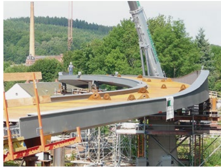
Bild 2.9-25 Montage mit Autokran
