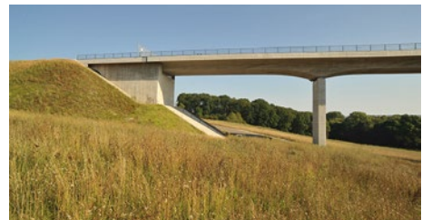
Bild 2.9-16 Widerlager mit Lagern (Foto: Ludolf Kron tal)
