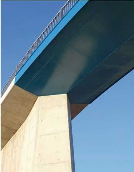
Bild 2.9-24 Integraler Anschluss am Widerlager
