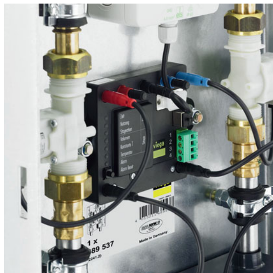
Abb. 2-6 Spülstation für PWH/PWC
