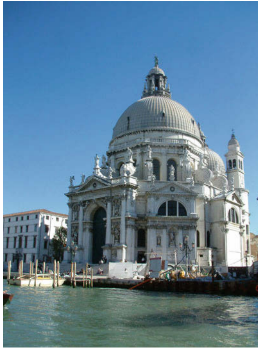
Bild 31 Die Kirche Santa Maria della Saluta in Venedig steht auf 1.156.627 Holzpfehlen [41]. Der mikrobiologische Abbau des biogenen Verbundwerkstoffs Holz geht unter Wasser bzw. vor allem im Schlamm des Untergrundes nur sehr langsam voran. © Radomil Binek.
