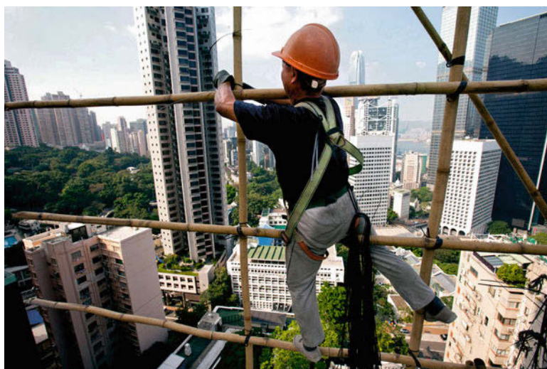
Bild 32 Der biogene Verbundwerkstoff Bambus dient in Südostasien immer noch als Gerüstbau-Material auch für sehr hohe Gerüstbauten [42]. Mit freundlicher Genehmigung von Palani Mohan.
