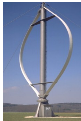
Abbildung 10: Darrieus Rotor [vgl. BWE 2013]
