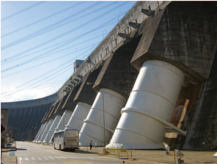
Abb. 2.3 Itaipu-Fallrohre und Turbinen
