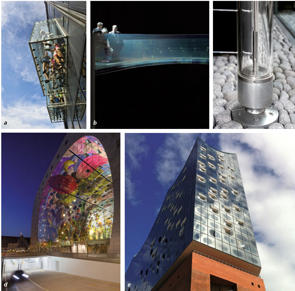
Abbildung 2.3 Beispiele für Glasanwendungen im konstruktiven Ingenieurbau: The Ledge bzw. Skydeck am Willis Tower in Chicago/USA (a); Ganzglas-Brücke Brücke 7 , hergestellt im Laminationsbiegeverfahren (b); Vorgespannte Stütze aus Borosilikatglas (c); Seilnetzfassade der Markthal in Rotterdam (d); Sphärische gekrümmte Verglasungen an der Fassade der Elbphilharmonie in Hamburg (e). (Bildnachweis: Skydeck Chicago at Willis Tower, Chicago (a), sedak GmbH & Co. KG, Gersthofen (b), Hi-Tec Glas, Grünenplan (c), Ossip van Duivenbode, Rotterdam (d))
