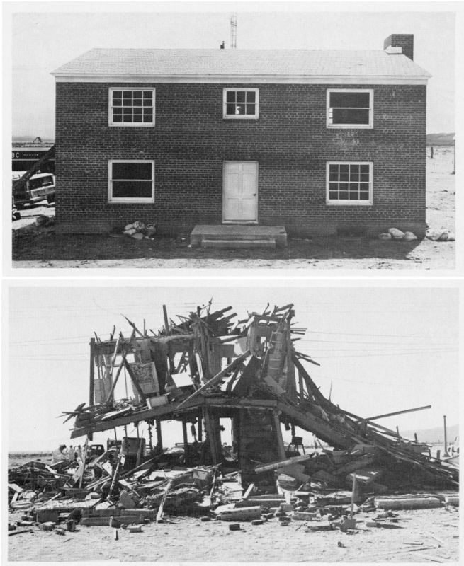
Abb. 2-27 Unverstärktes Steinhaus vor und nach einem Nukleartest (maximaler Überdruck 35 kPa)
