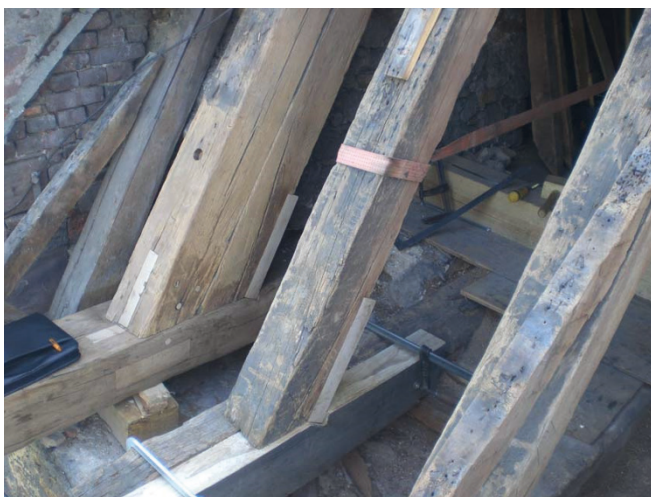
Bild 2-4 Verstärkung der Sparrenfußpunkte mittels Knaggen (Foto: © Eifert Holzbau GmbH).
