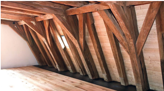
Bild 2-1 Das Solms-Hohensolmscher Schloss verfügt über einen dreigeschossigen, gotischen Dachstuhl mit 200 Dachbalken (Foto: © Eifert Holzbau GmbH).
