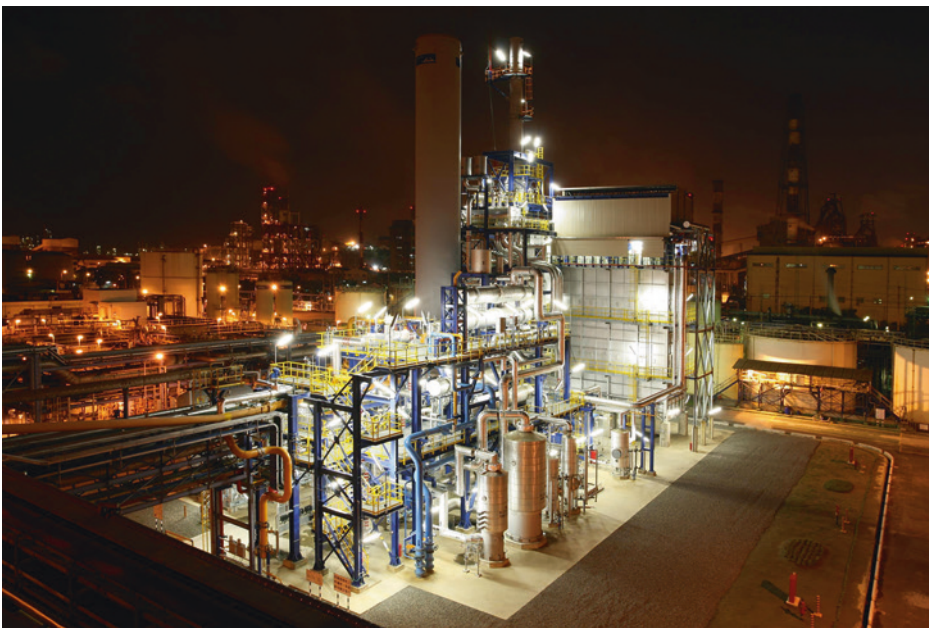
Abb. 1.3 Wasserstoff wird durch Dampfreformierung aus Erdgas gewonnen. Das Photo zeigt eine Anlage der Firma Linde. (Bild Linde AG)
