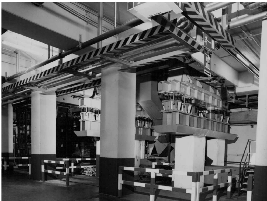
Рис. 1-13: Применение пружинных амортизаторов для виброизоляции
